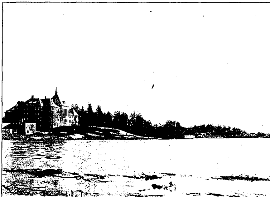
Fig. 35. Hufvudbyggnaden från sjösidan.
