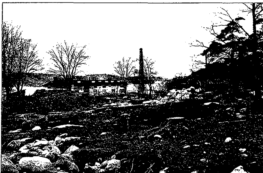
Fig. 25. Tomten färdig för grundläggningsarbetena. (I fonden synes den gamla Radiatorsfabriken).
