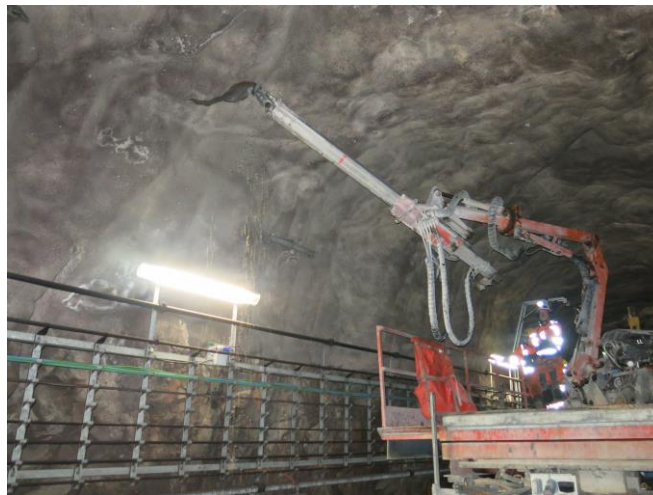
Figur 26. Borrhning av injekteringshål vid läckage 10+440.
