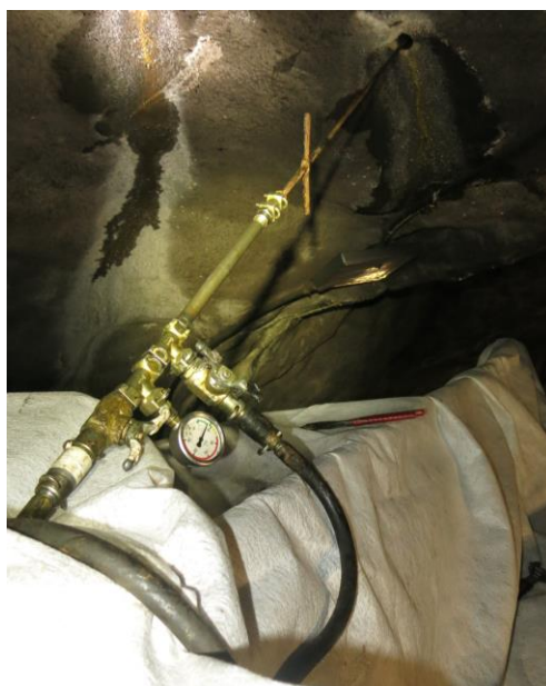
Figur 20. Injektering vid läckage 7+618. Injekteringsmanschett med manometer för mätning av injekteringstryck.
