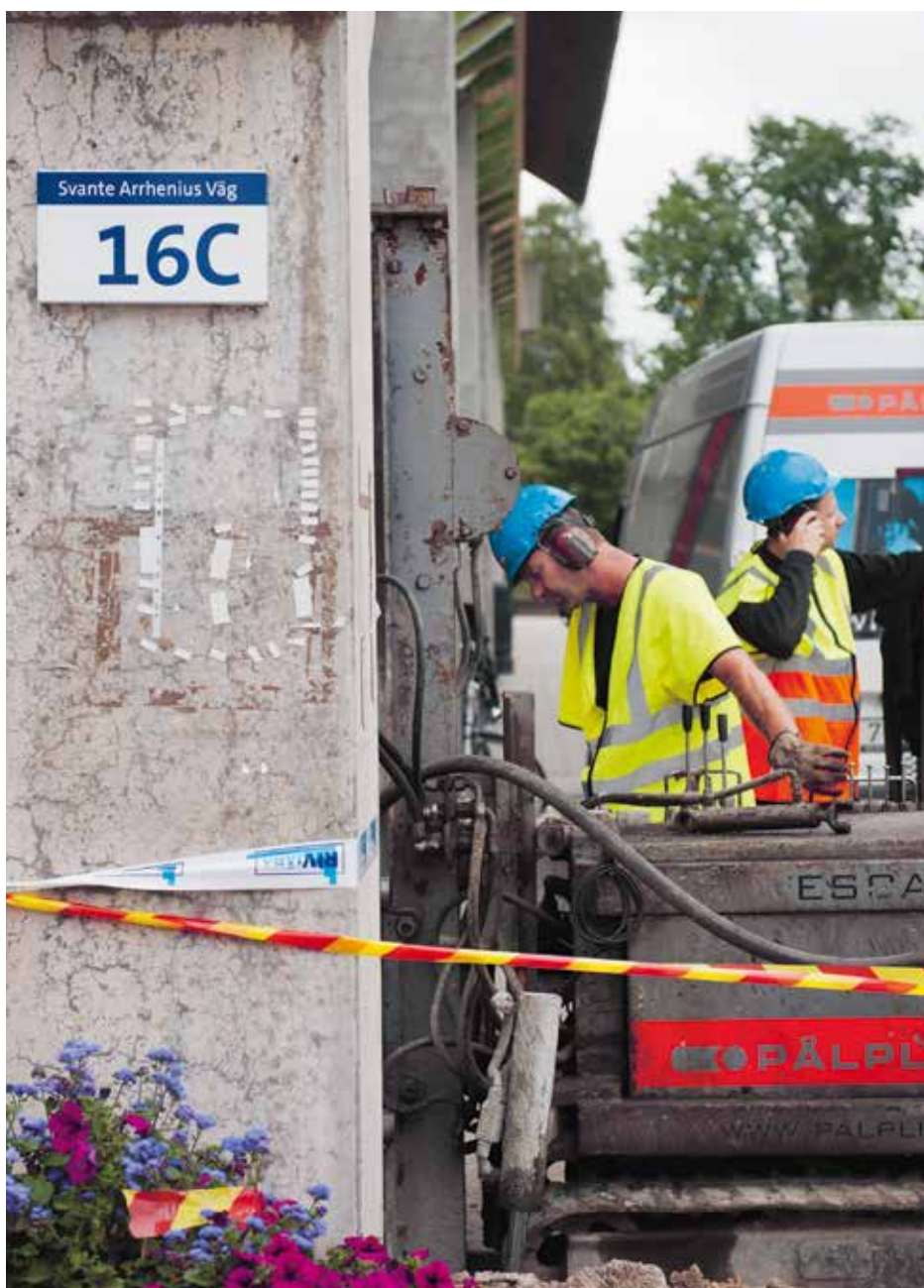
Sprickbildning finns i pelare och balkar i Arrheniuslaboratoriet (se bilden högst upp). Reparationerna beräknas vara klara om två år.
