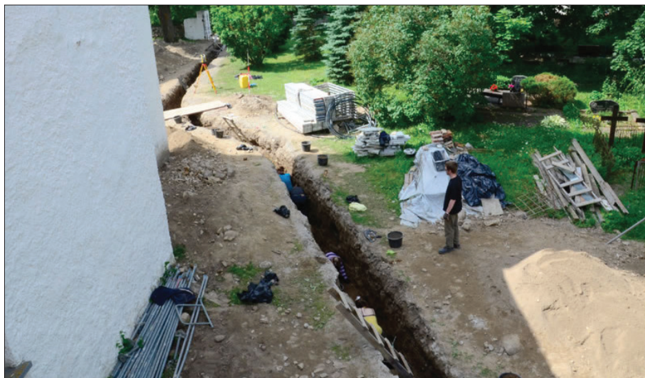
Fig. 9. Öppet schakt på Kose kyrkogård (foto: Raido Roog).
