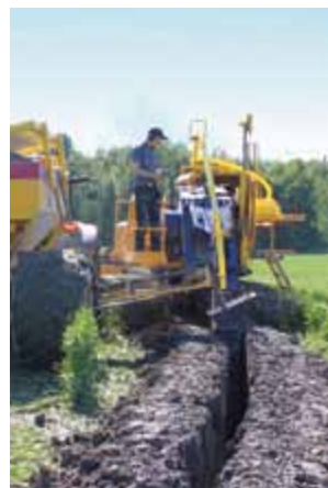
▲ När ett kalkfilterdike anläggs blandas kalk in i återfyllnadsjorden. Kalken binder fosfor som är löst i vattnet.
