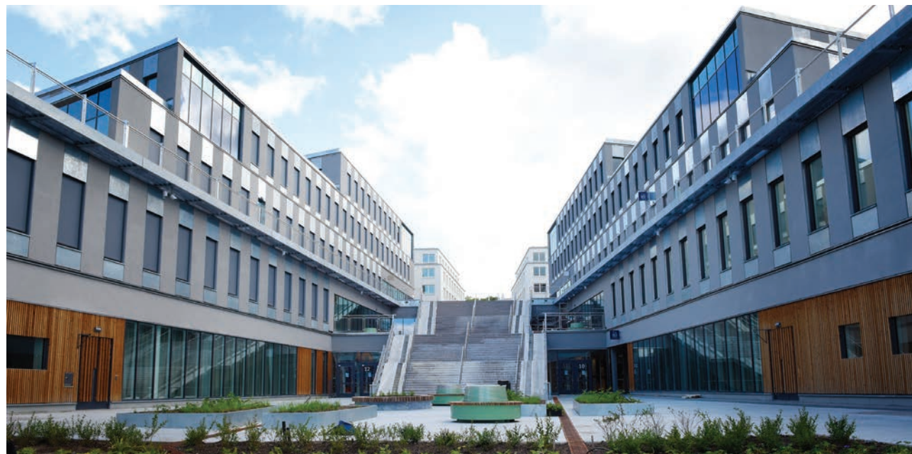
Albanotrappan mellan Albano hus 2 och 4. Foto: Ingmarie Andersson.
