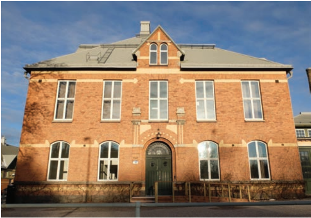
Byggnaden Hovbeslaget i Kräfteriket. Foto: Fastighetsavdelningen.
