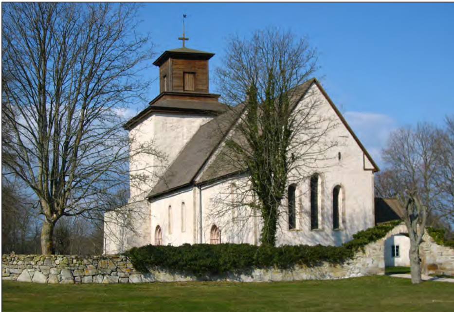
Fig. 137. Vamlingbo kyrka från sydost.
