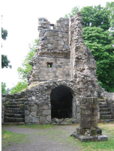
Fig. 9. Västpartiet i S:t Pers kyrka är utformat som s.k. västverk omkring 1230 men byggmästaren har inte förstått meningen med det hela. Byggherren Knut Långe har beordrat ett statusbygge av en sort som finns i Visby. Hans sigillring har en bild av lamm med kors, en gotländsk symbol.
