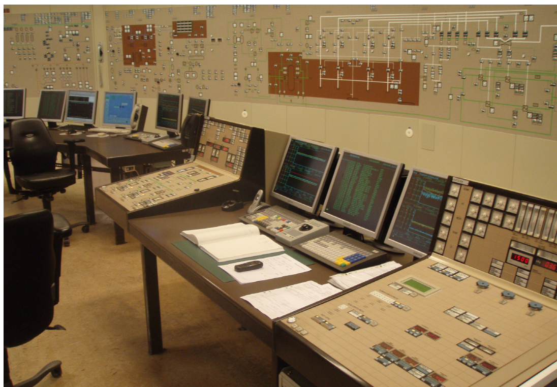
Figur 2.2. Ljusutformning i Forsmark 3 för turbinoperatörer som ger en svag belysningsnivå (<200 lux) för normalbetingelsen.
